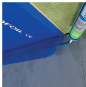
DAFA foliemassa används för att ge en god vidhäftning mellan diffusionsspärrn och underlag som gips, betong eller obehandlat trä.
